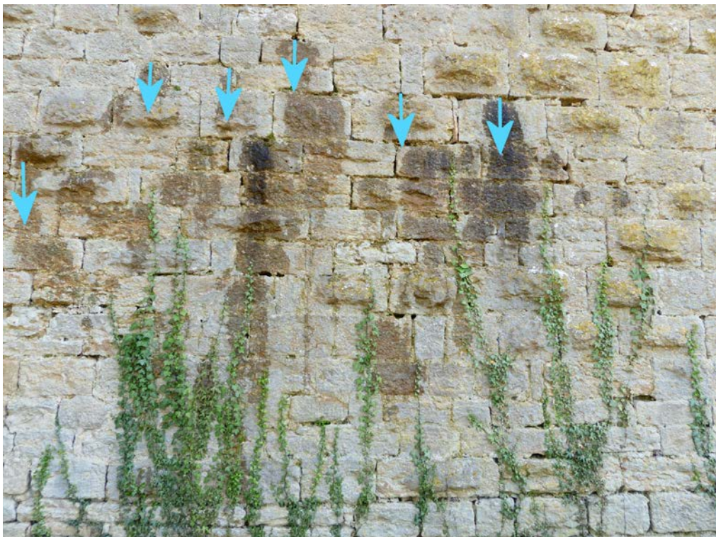
Sortie d'eau. Niveau : 247,98 m. Le ruissellement a entraîné l'altération et la desquamation des moellons calcaires situés en-dessous
