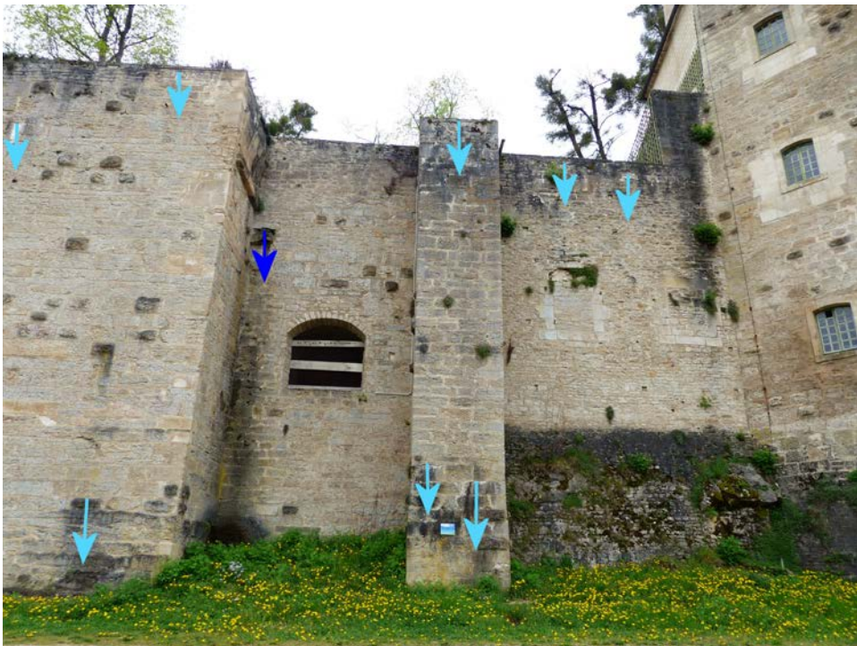
Sorties d'eau sur l'ensemble du parapet Buffon avec traces de calcin. Sorties d'eau au bas des murs et contrefort, avec calcin. Chanlatte. Niveau de sortie de l'eau : 251,68 m.
