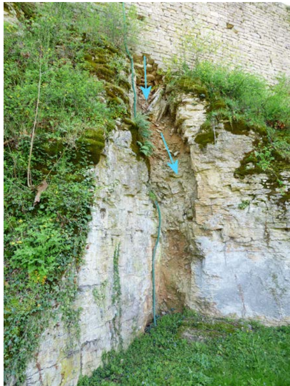
Destruction au point de connexion entre le mur du parapet ouest et la roche. Erosion de la roche. Connexion roche/mur du parapet : 252,07 m
