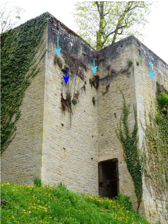
Sorties d'eau sur l'ensemble du parapet Buffon avec traces de calcin. Niveaux de sortie de l'eau de la chanlatte : 252,90 m.
