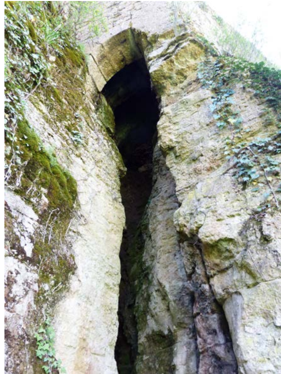
Faille ancienne renforcée par des arches. Affouillement sous le bastion.
