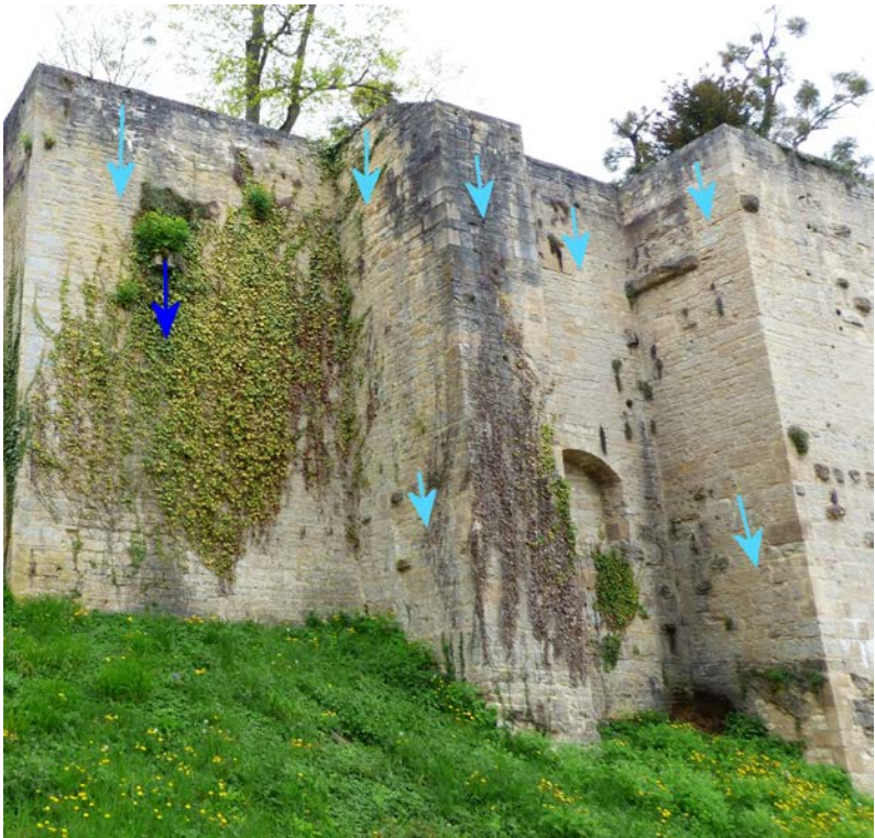
Sorties d'eau sur l'ensemble du parapet Buffon avec traces de calcin. Sorties d'eau le long des murs et contrefort, avec calcin. Chanlatte
