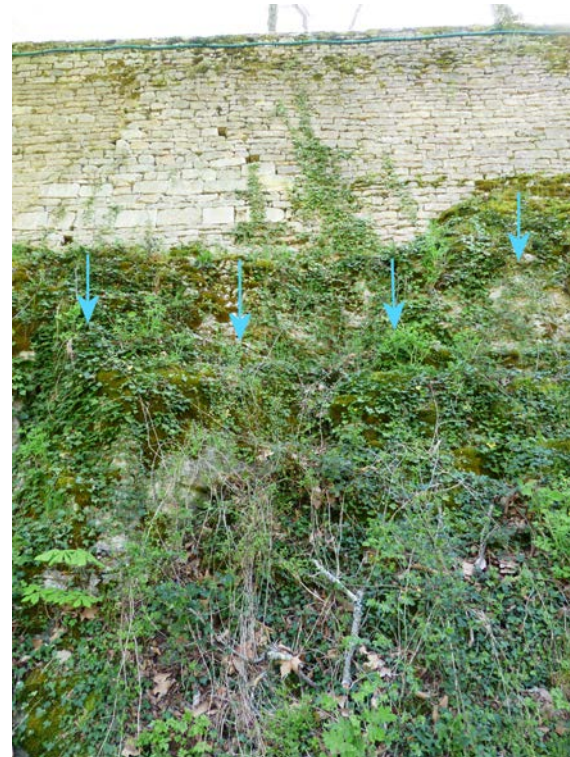
Humidité de la connexion entre le parapet de l'allée de Bacchus et la roche
