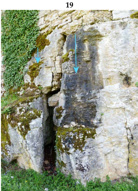
Suintements d'eau au point de connexion entre mur et roche
