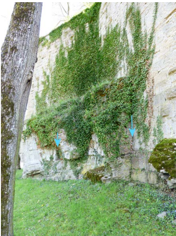
Sorties d'eau à la connexion entre mur et roche. Altération de la roche
