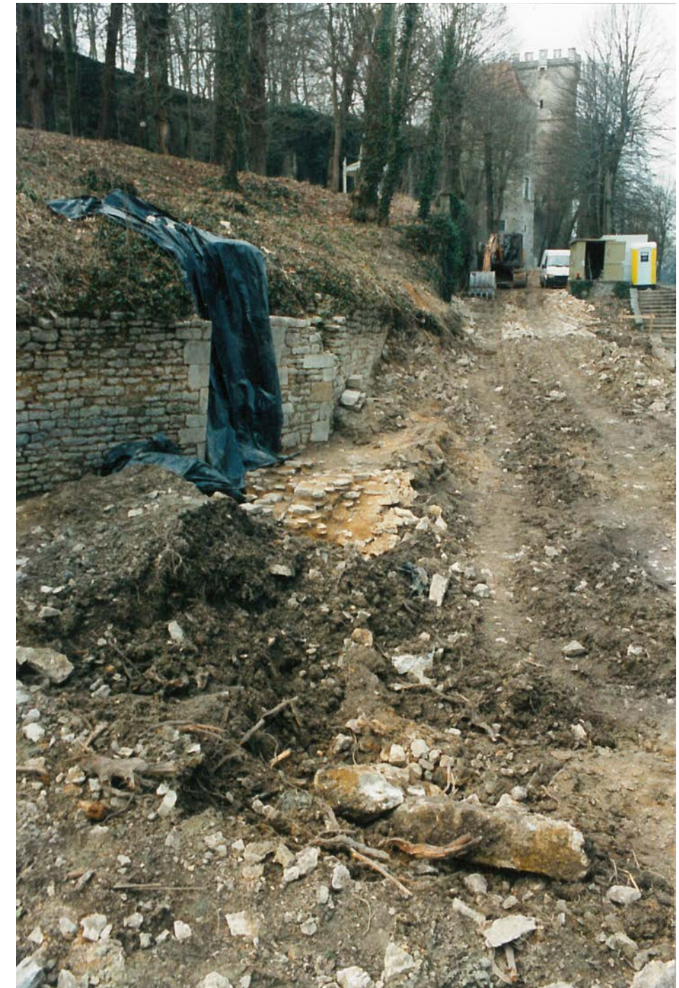
Décapage de la 3 ème terrasse lors de la campagne de restauration 1994-1998. Dégagement d'un corroi d'argile
