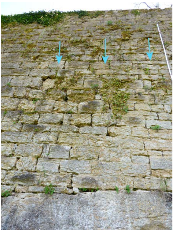
Ligne de sortie d'eau. Niveau : 251,82 m. Le ruissellement a entraîné l'altération et la desquamation des moellons calcaires situés en-dessous.
