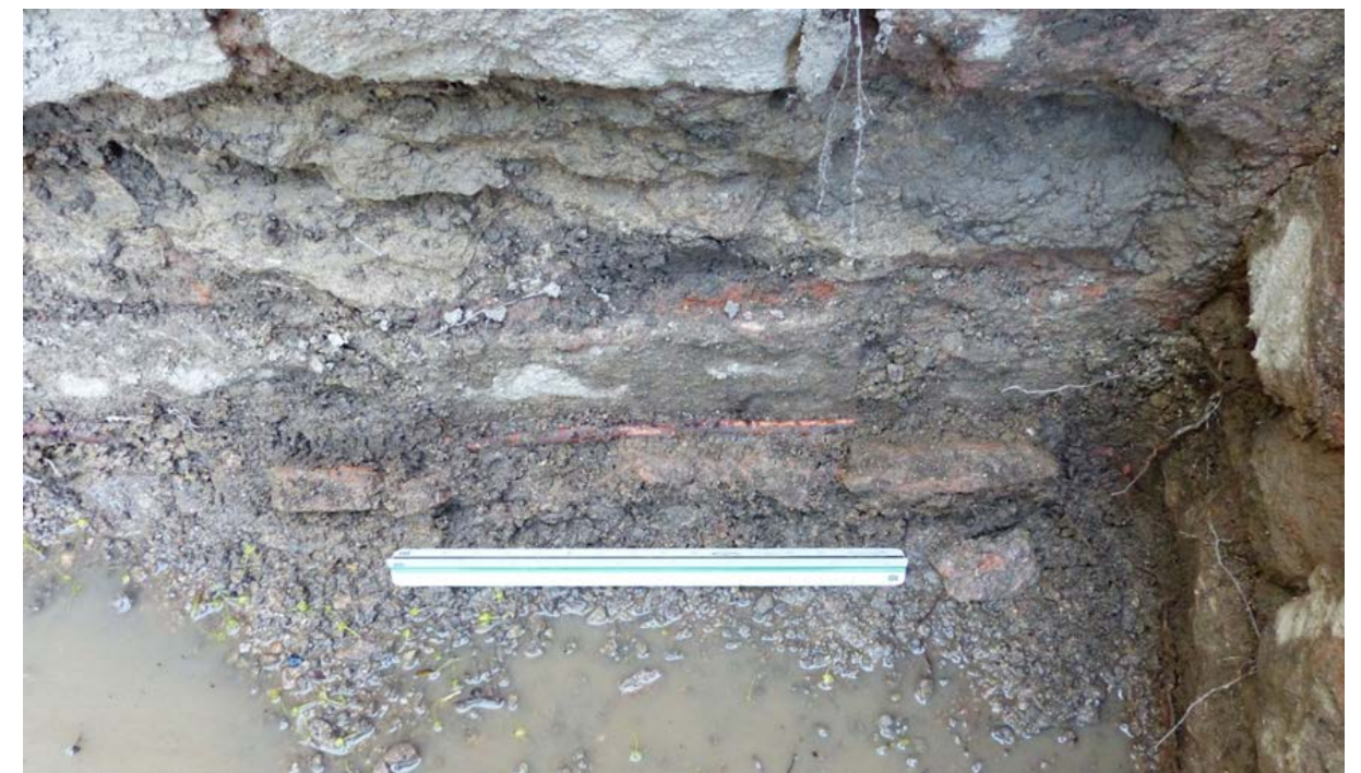
Bassin de la 3 ème terrasse. Parement Nord, Présente d'un enduit au mortier de tuileau sur le mur de terrasse Nord ainsi que de carreaux de terre cuite résiduels Photo : A. Allimant-Verdillon
