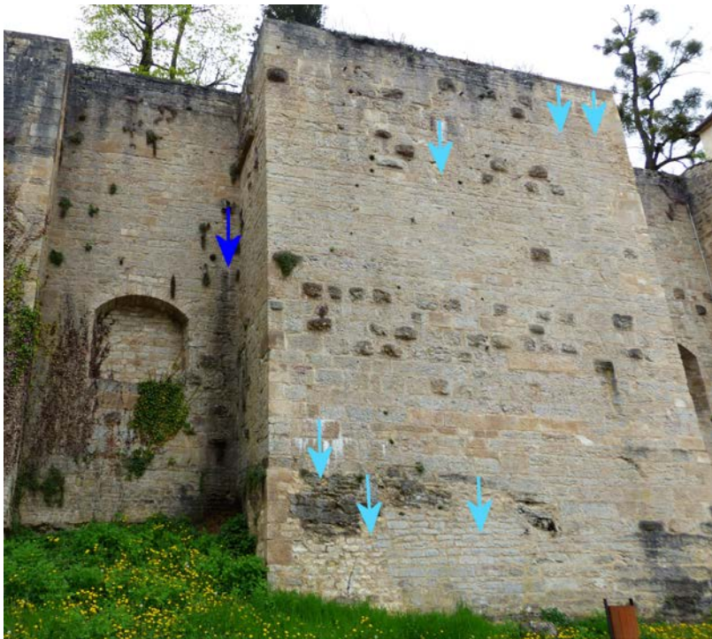
Sorties d'eau sur le parapet avec traces de calcin. Sorties d'eau au bas des murs, avec calcin. Chanlatte. Niveau de sortie de l'eau : 251,44 m.
