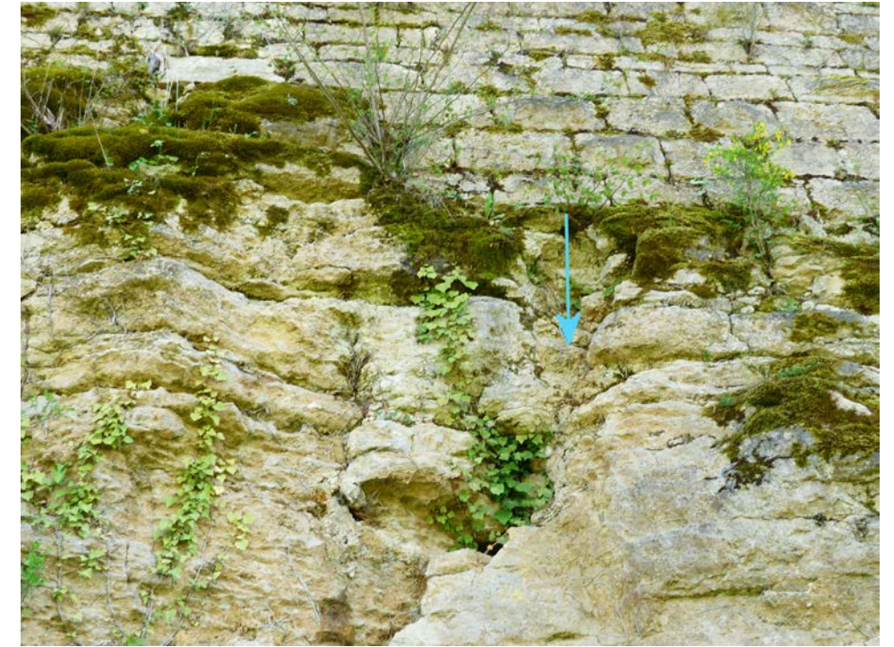
Délitage de la roche sous la maçonnerie du mur.
