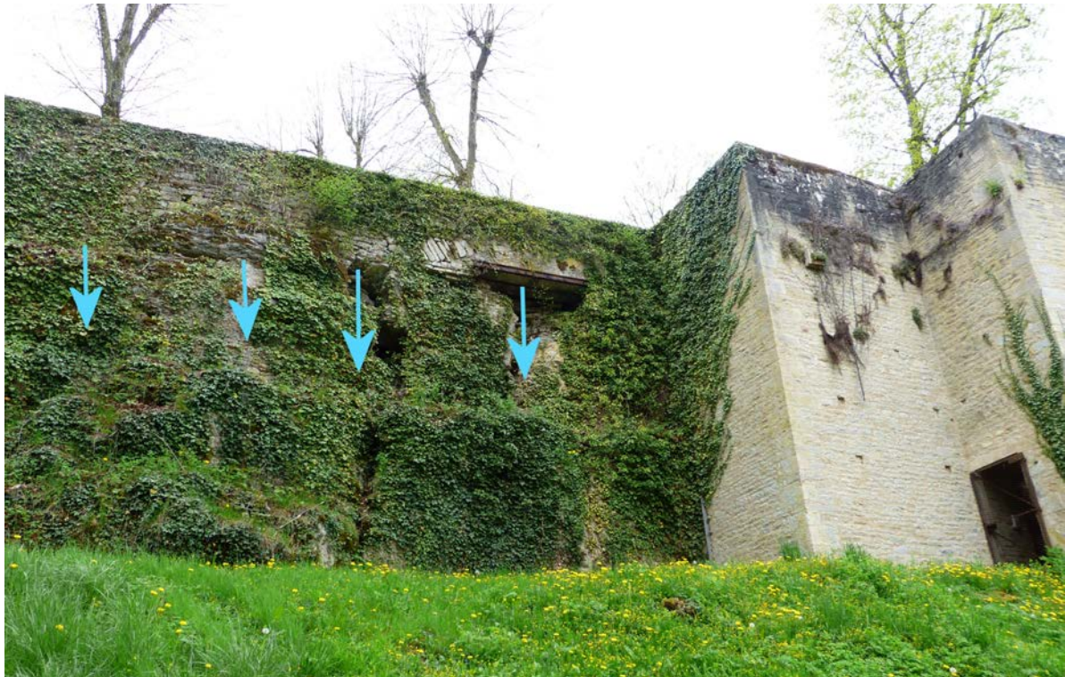
L'eau s'évacue le à la connexion entre le mur et la roche. Création de failles. La faille Nord a entraîné l'effondrement du mur, conforté récemment par la pose d'un IPN métallique.
