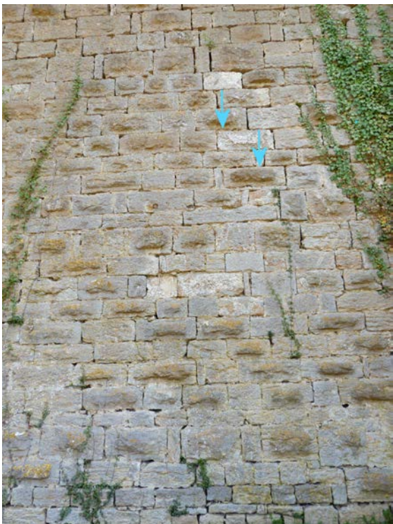
L'eau s'évacue le long d'une fissure. Le ruissellement a entraîné une perte de matière (mortier). Avec altération et desquamation des moellons calcaires situés en périphérie et en-dessous. Niveau de sortie de l'eau : 250,34 m
