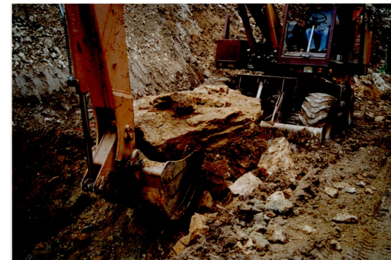
Fig. 15 : Élément de rocher mis en évidence lors du terrassement. Ces blocs appartiennent certainement à la roche naturelle située au-dessus des niveaux argileux et que l'on retrouve dans les éboulis de pente. (Dia 3, n° 11, 09/2001).
