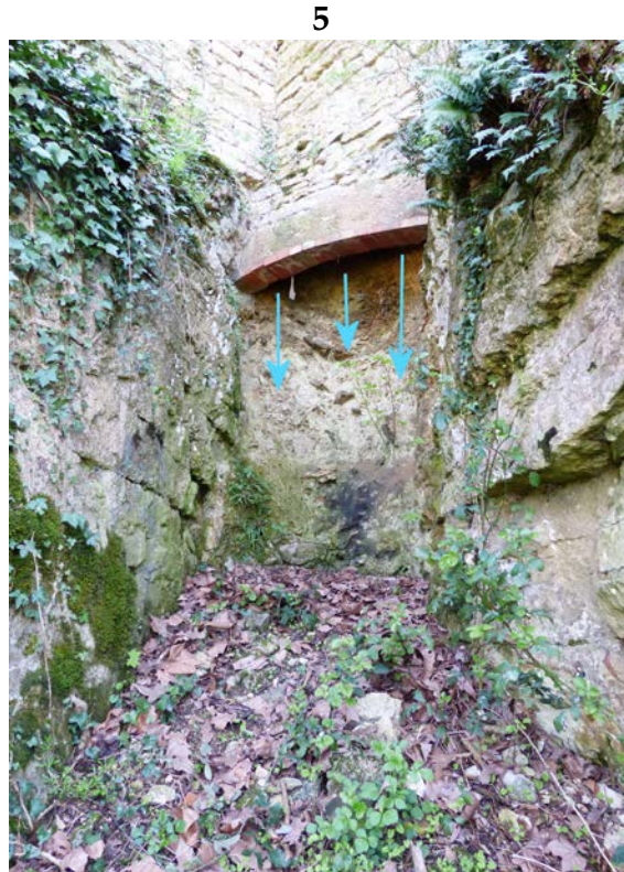
Angle du bastion de Bacchus. Erosion de la roche par ruissellement
