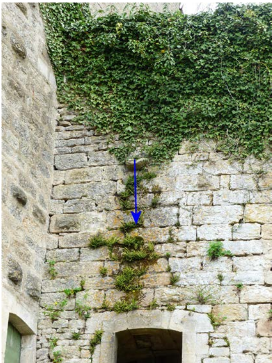
Chanlatte. Niveau de sortie de l'eau : 252,08 m. Le ruissellement a entraîné l'altération et la desquamation des moellons calcaires situés en-dessous.
