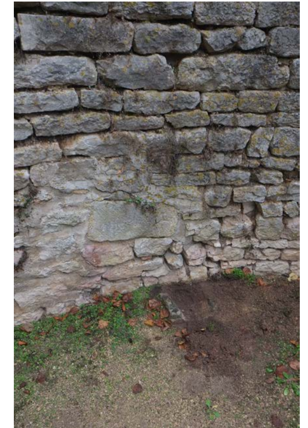
Traces de chanlatte et bouchage situés au Nord du mur en demi-cercle Photo : A. Allimant-Verdillon. Avril 2016.
