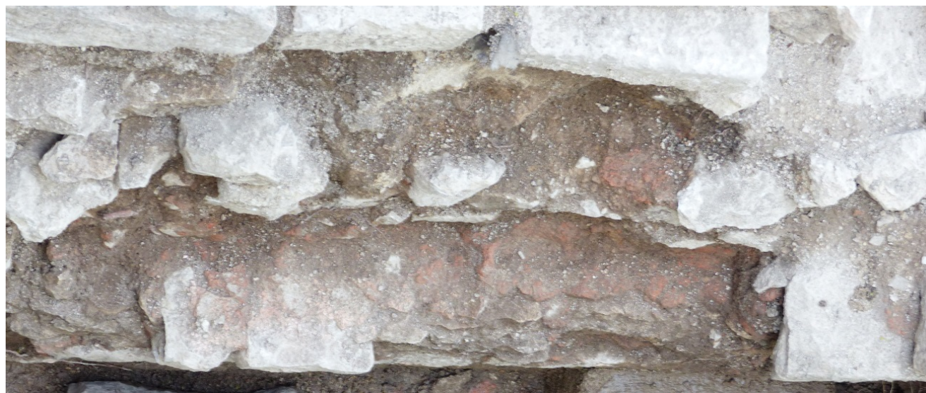
Bassin de la 3 ème terrasse. Parement Est. Moellons de calcaire liés au mortier de tuileau Photo : A. Allimant-Verdillon
