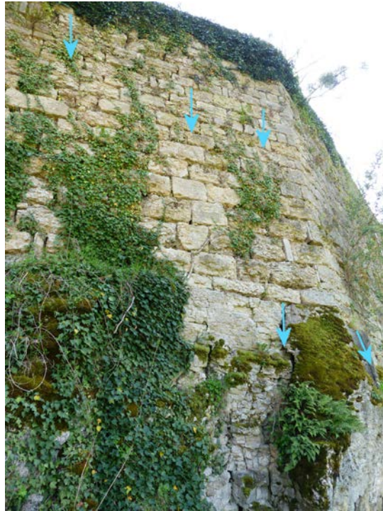
Ligne de sortie d'eau. Le ruissellement a entraîné l'altération et la desquamation des moellons calcaires situés en-dessous. Sorties d'eau à la connexion entre mur et roche. Création d'une faille
