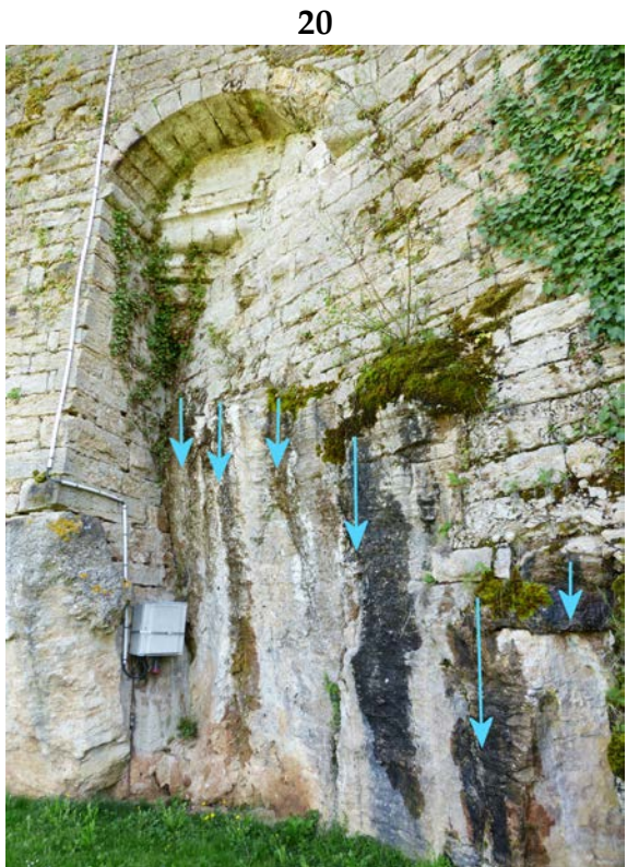
Suintements d'eau au point de connexion entre mur et roche
