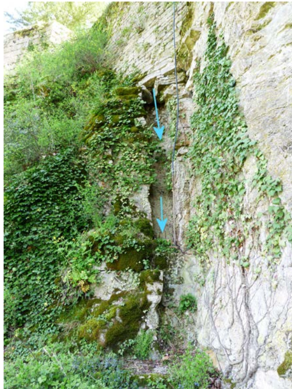
Sortie d'eau à la connexion entre le parapet et la roche. Faille en formation. Phénomène d'érosion
