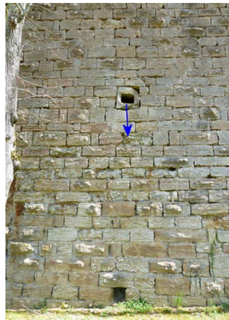
Chanlatte. Niveau de sortie de l'eau : 249,74 m. Le ruissellement a entraîné l'altération et la desquamation des moellons calcaires situés en-dessous.
