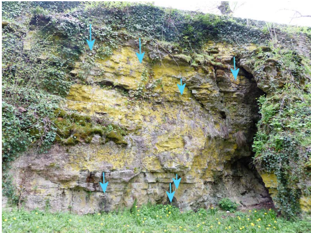
Ruissellement d'eau sur le plateau de roche avec infiltrations. Faille ancienne surplombée par le parapet Buffon. Perte de matière et déchaussement du mur au point d'ouverture de la faille.
