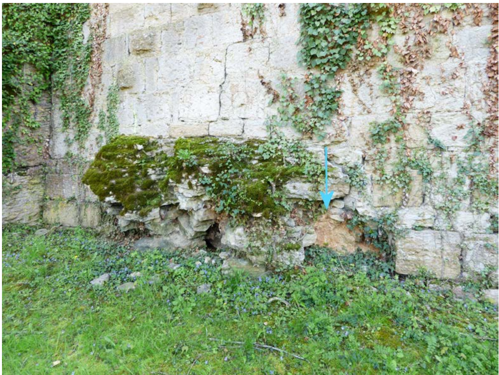
Sorties d'eau à la connexion entre mur et roche. Altération de la roche
