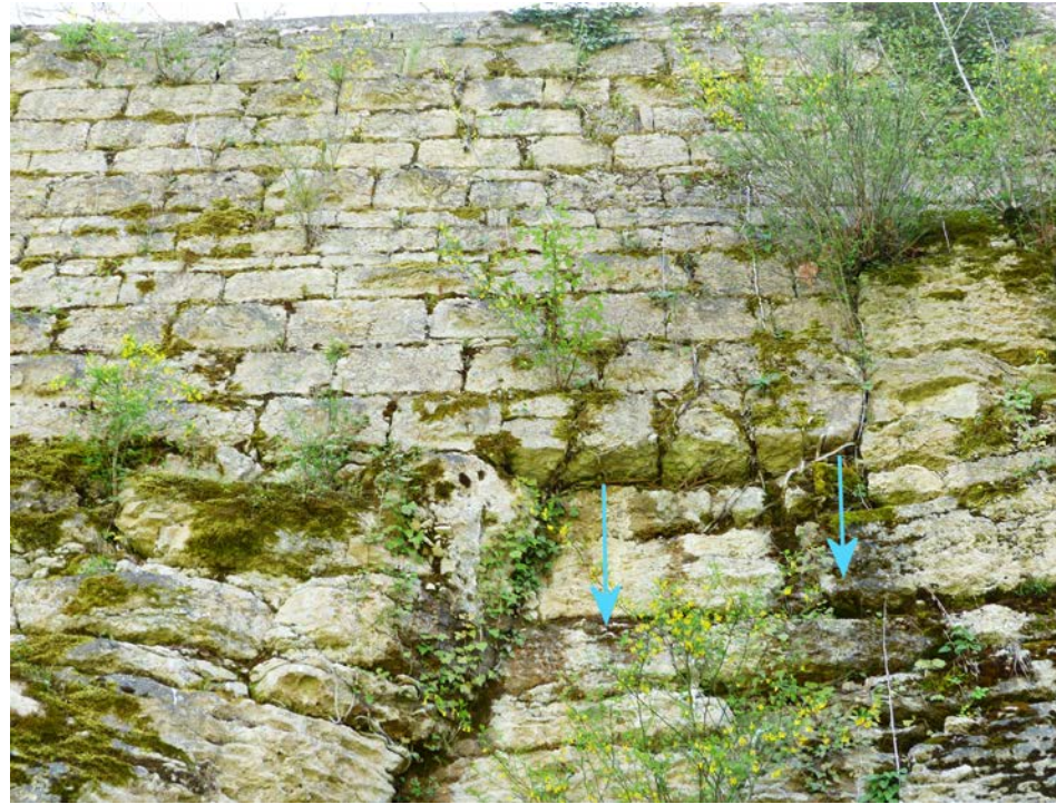
Délitage de la roche sous la maçonnerie. Sortie d'eau à la connexion entre le mur et la roche : 251,96 m
