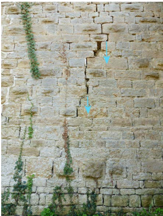
L'eau s'évacue le long d'une fissure. Le ruissellement a entraîné une perte de matière (mortier). Avec altération et desquamation des moellons calcaires situés en périphérie et en-dessous.
